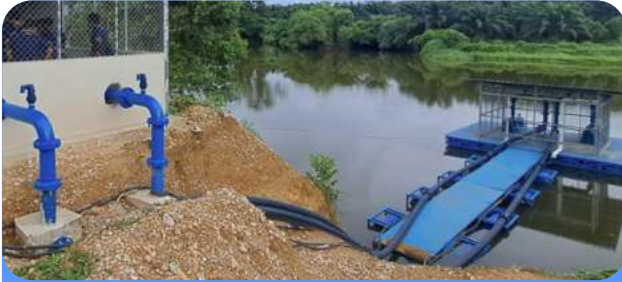
ออกแบบและติดตั้งชุดปั๊มน้ำจากแหล่งน้ำ
