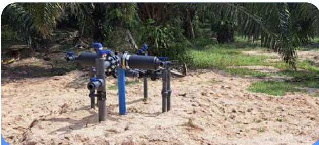
ติดตั้งชุดกรองน้ำและวาล์วควบคุมประจําโซนให้น้ำ
