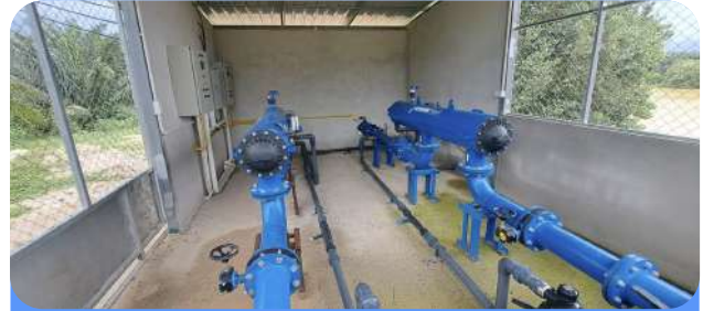
ติดตั้งชุดกรองน้ำเกษตรเพื่อกรองน้ำก่อนเข้าระบบน้ำหยดในแปลง
