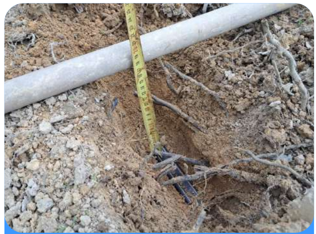
ฝังท่อน้ำหยดลึก 20 ซม. จากผิวดิน
