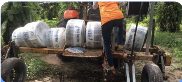
ท่อน้ำหยดรุ่น DripNet™ PC ที่ถูกใช้ในการติดตั้งในแปลง
