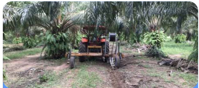
การติดตั้งวางท่อน้ำหยดใต้ดินในแปลงปลูก
