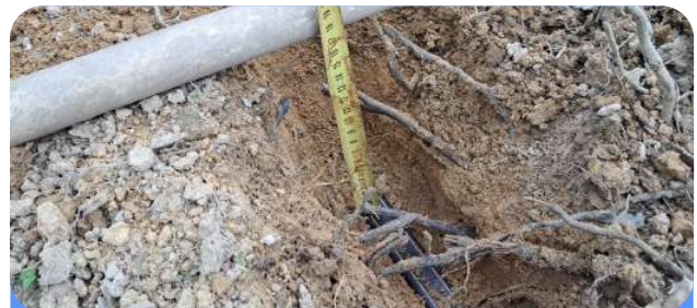
วางท่อน้ำหยดลึก 20 ซม. จากผิวดิน
